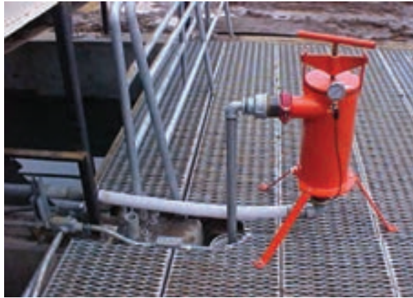
شکل ۲۶-۶- تأسیسات و تشکیلات یک فیلتر توری دار
