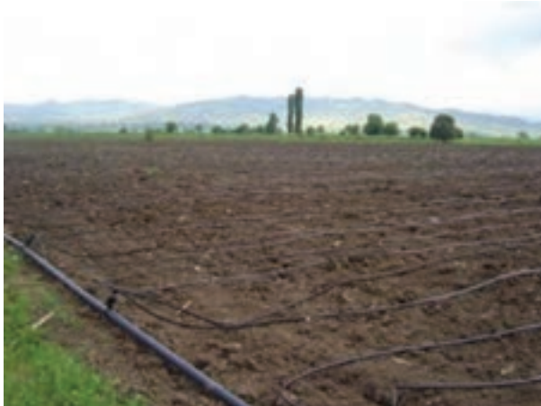
شکل ۴-۶- لوله‌های نیمه اصلی و جانبی
